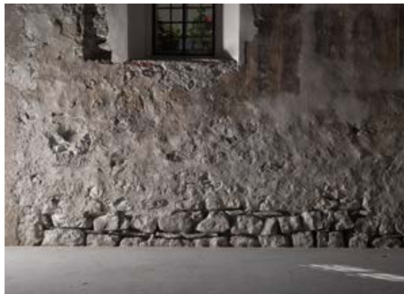
Particolare del fronte sud durante la fase di sottrazione degli intonaci non originali.
